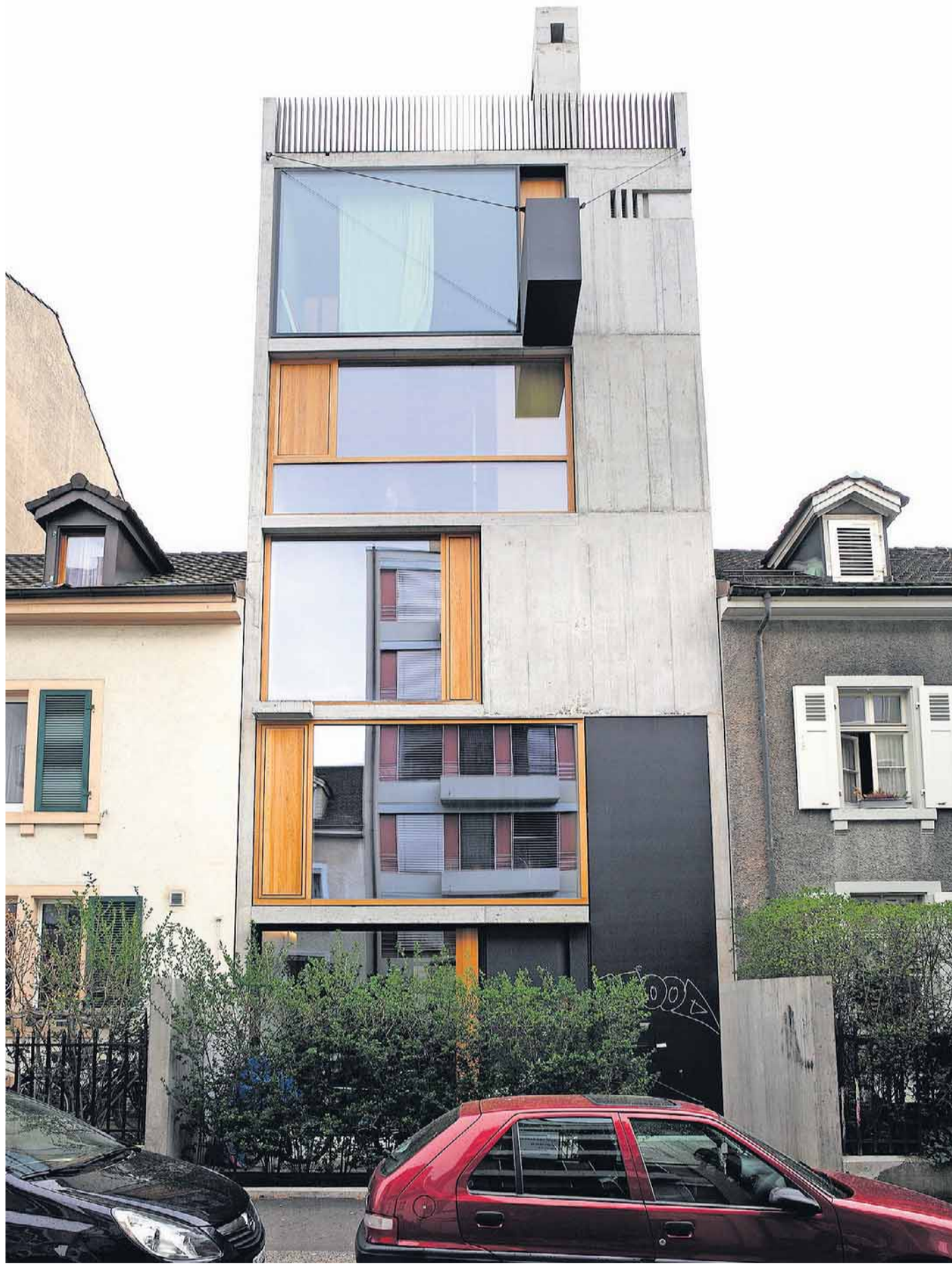
Wie ein Zahn ragt das Wohnhaus am Bläsiring zwischen zwei Arbeiterhäuschen heraus. Dafür gabs den «Architekturpreis Beton».
